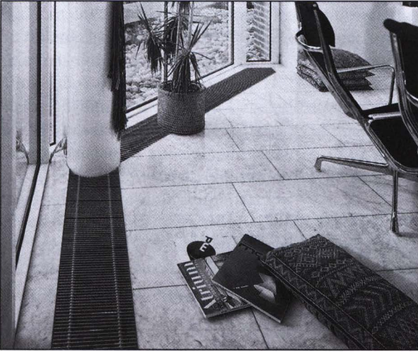
Şekil 16.34. DÖŞEME TİPİ KONVEKTÖR UYGULAMA ÖRNEĞİ 1
