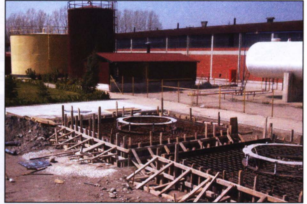
Şekil 22.56. LNG TANKI TEMELİ
