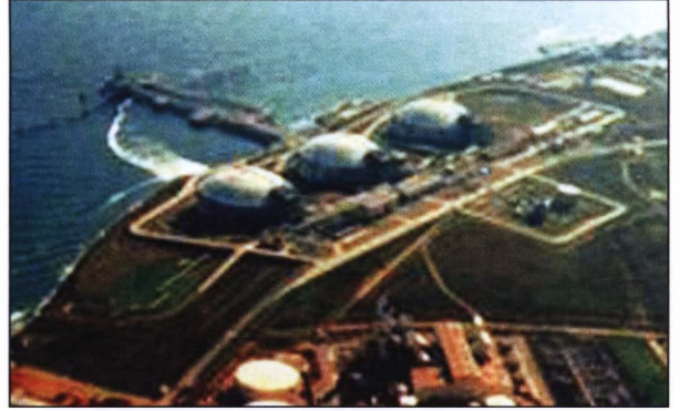
Şekil 22.49. MARMARA EREĞLİSİ LNG DEPOLAMA TERMİNALİ
